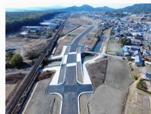
早咲改良工事
