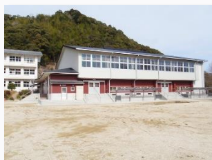
四万十市立藤岡中学校屋内 運動場改築工事
