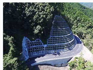
山のみち第92号 幹線林道開設事業 中村・大正線 3-1 工区工事
