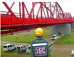
県道中村下ノ加江線(四万十川橋)防災・安全交付金工事 (修繕工事)
