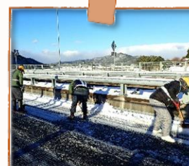
国道の除雪作業
