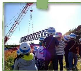
工事現場見学
