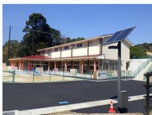
八束地区防災拠点基地・八束保育所（合築） 建設工事（建築主体工事）
