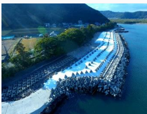
初崎堤防（その1）外工事
